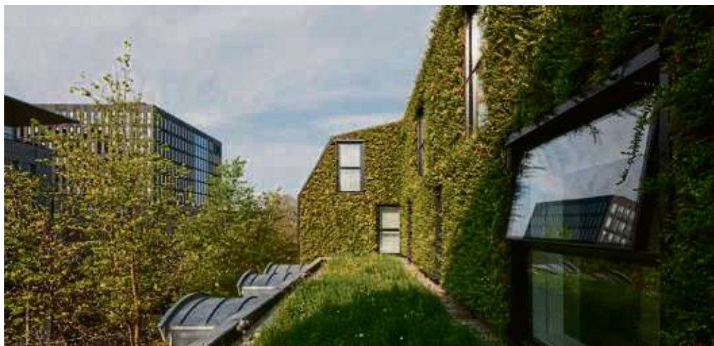
Begrünte Wände halten das Innere von Gebäuden kühl.
