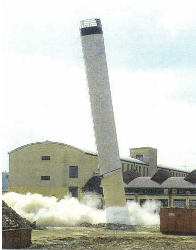
22. August 2002: Der Abriss des Werkgeländes beginnt
