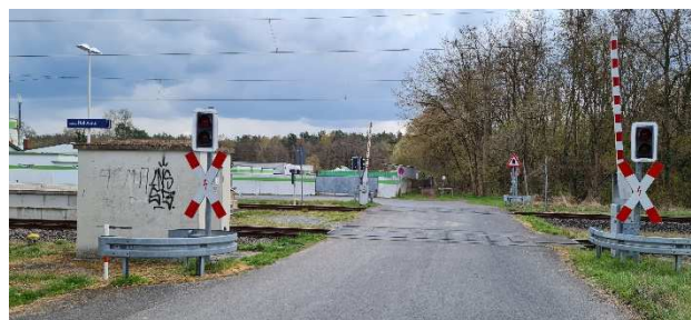
BÜ bei km 19,7 (Zufahrt Betonwerk)
