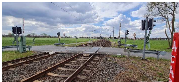
BÜ bei km 20,7 (Zufahrt Klärwerk)
