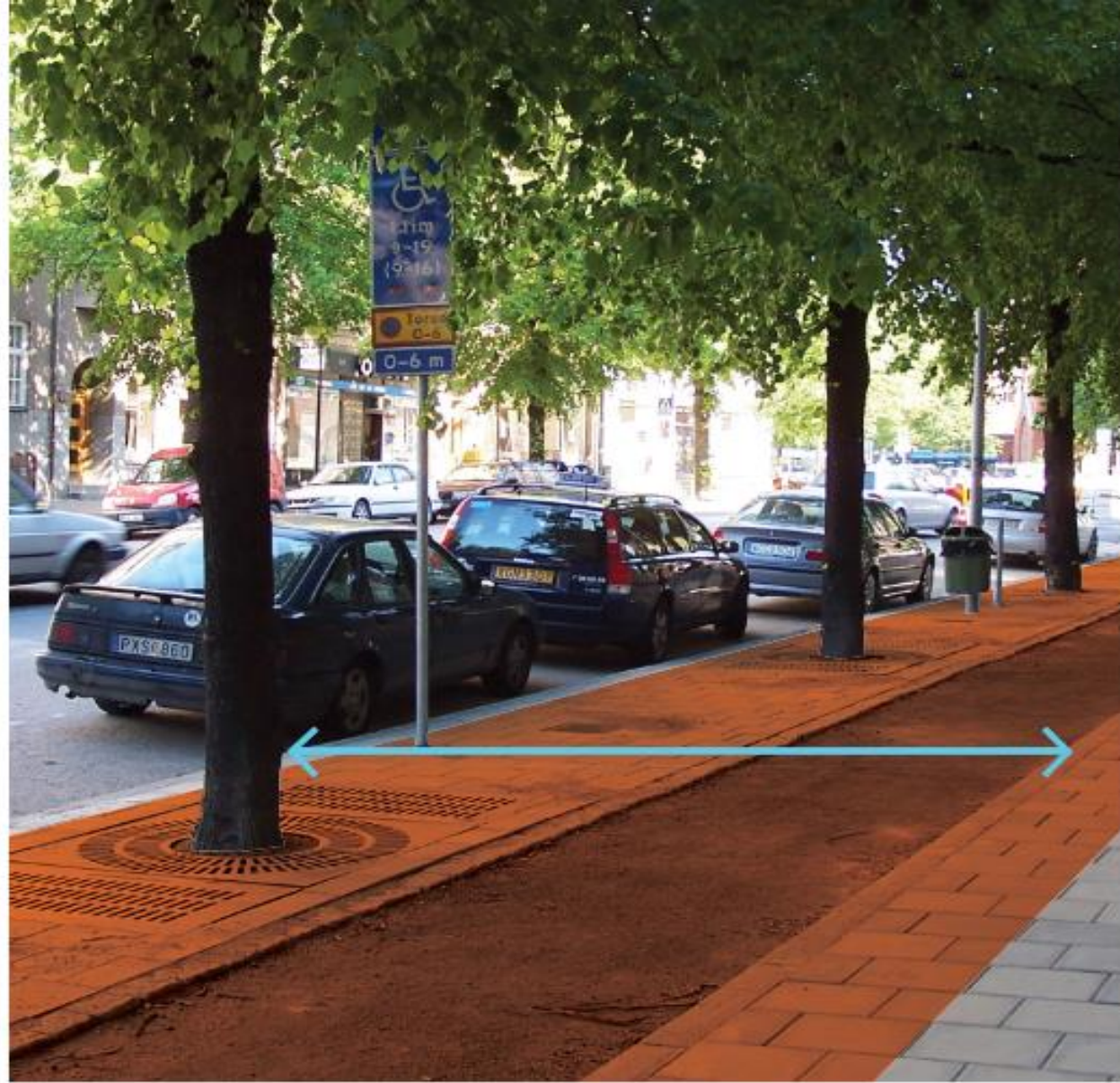
Wiederherstellung einer neuen Oberflächenschicht mit Betonplatten. Rahmen für Baumgitter wird auf Betonkasten oder Betonschwellen ausgelegt. Die fertige Anlage hat ein wurzelbares Pflanzvolumen von 15 m 3 für jeden Baum. Das orangefarbene Feld illustriert in etwa die Breite der zusammenhängenden Fläche
