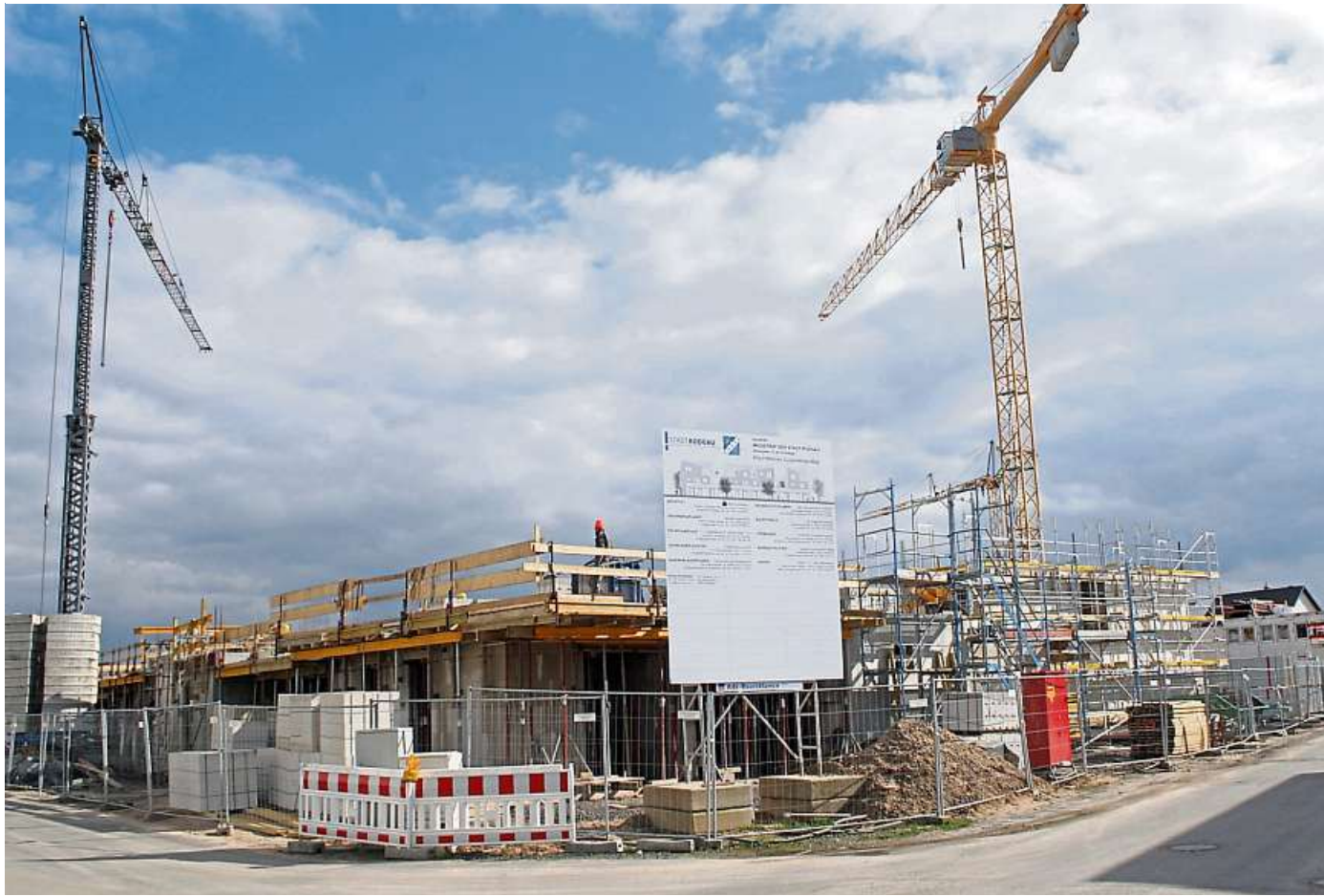
Im Erdgeschoss: Betreuungsräume. Und über der Kita: Mietwohnungen. Einen derartigen Kombi-Komplex lässt die Stadt Rodgau im Baugebiet Hainhausen-West errichten (Foto). Das Projekt zählt zu einer Vielzahl von Kita-Bauten, die in Hessen von der Problematik „Fördergelder fließen nicht“ betroffen sind. Ob die Landesregierung mit einem neu aufgelegten und üppiger bestückten Zuschussprogramm für Heilung sorgen kann, steht derzeit in den Sternen.
