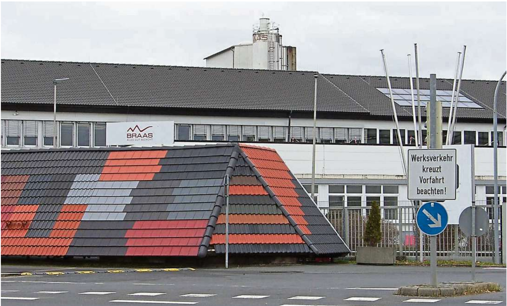
Blick auf das Werksgelände der Firma Braas in Heusenstamm. Der Dachziegel-Spezialist sorgt für kommunalpolitische Diskussionen. Dabei spielt das Stichwort „Sandabbau“ eine zentrale Rolle.
