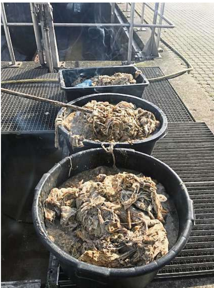
EKELFRACHT: Weil sich die Lagen von feuchtem Toilettenpapier nicht zersetzen, verstopfen sie die Pumpen der örtlichen Kläranlage. Und dann ist eine mit einem erheblichen Aufwand verbundene und obendrein auch ziemlich kostspielige Reinigung nötig. Foto: Stadt Mörfelden-Walldorf
