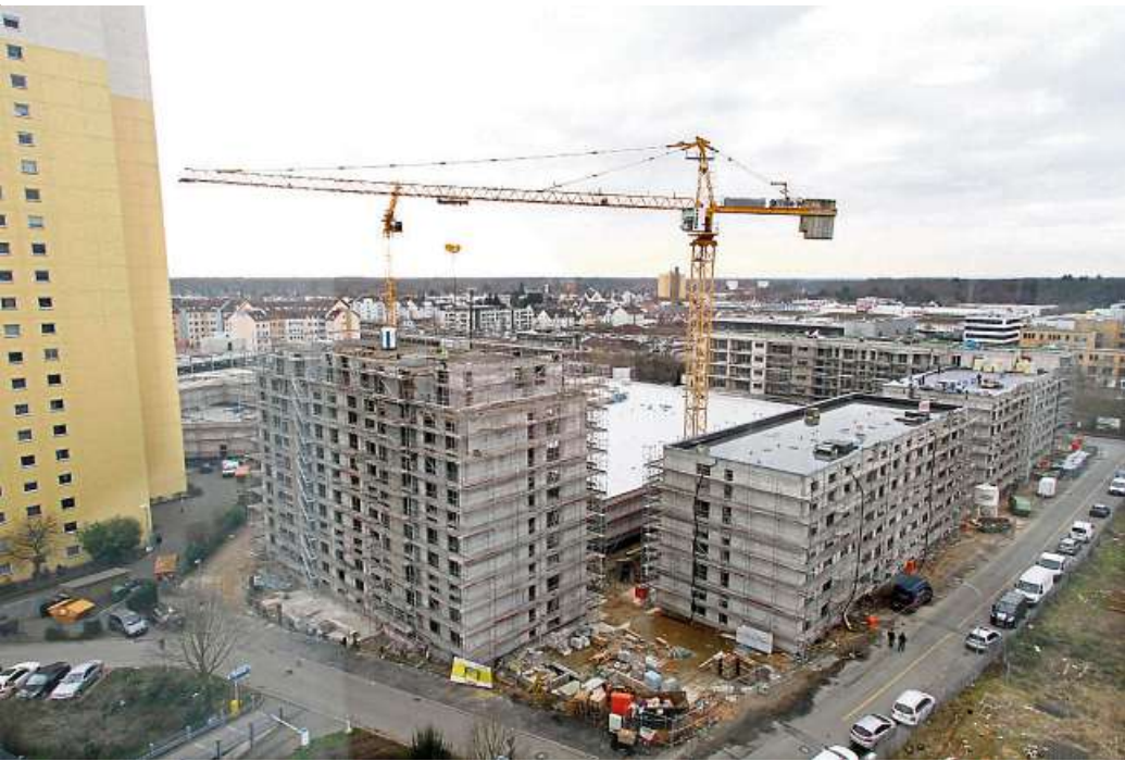
ALS MÄCHTIGER GEBÄUDERIEGEL entpuppt sich das seit geraumer Zeit im Bau befindliche Quartierszentrum an der Liebigstraße, das Wohnungen, ein Hotel und ein Einkaufszentrum umfasst. Foto: Sorger/Stadt Langen
