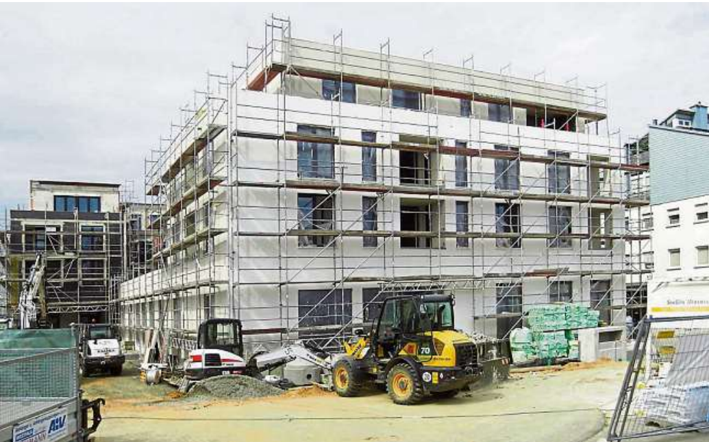
Großer Bau in Heusenstamm: Arbeiten auf der Zielgeraden
