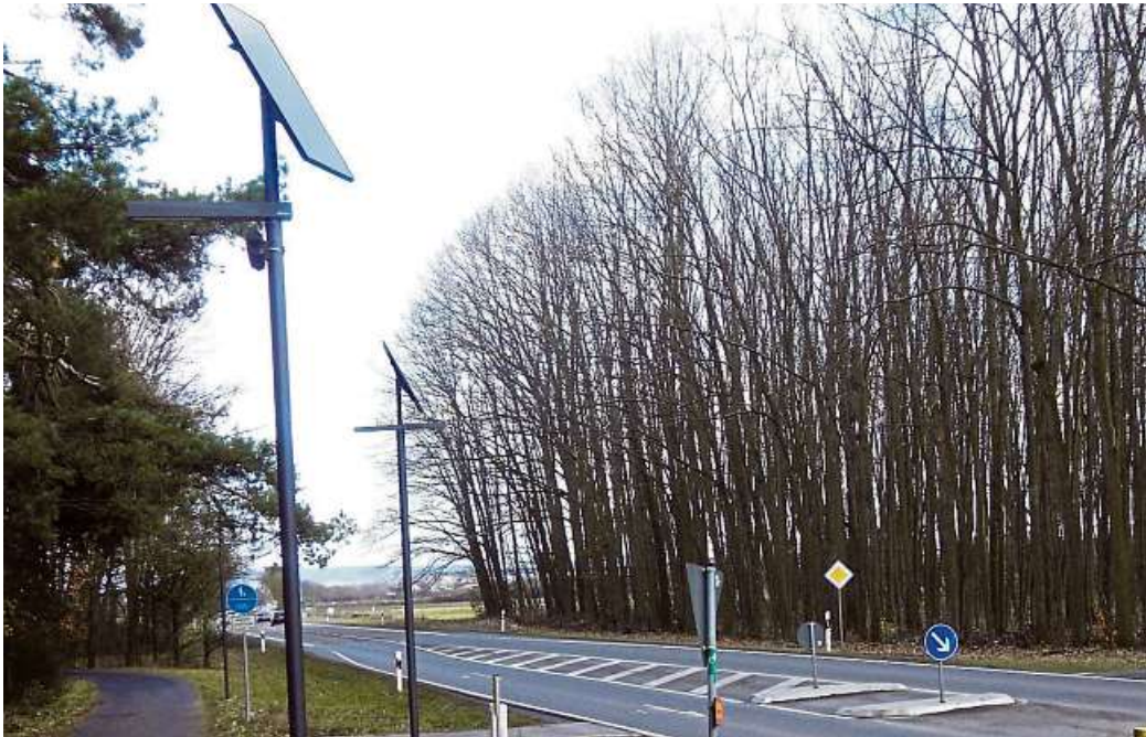
Masten mit Photovoltaikmodulen: So präsentiert sich die neue Lichtanlage an der Schnittstelle von Radfernweg und Kreisquerverbindung zwischen Dietzenbach und Rodgau. Radfahrer und Fußgänger steuern das Lampen-Ensemble mit ihren Bewegungen wie von Geisterhand.
