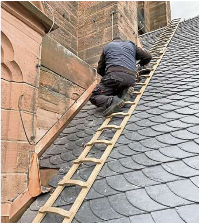
FILIGRANE FLEISSARBEIT FÜR SCHWINDELFREIE: Ein Spengler befestigt Kupfereinfassungen auf dem Dach der Stadtkirche. Fotos: Christiane Thomas
