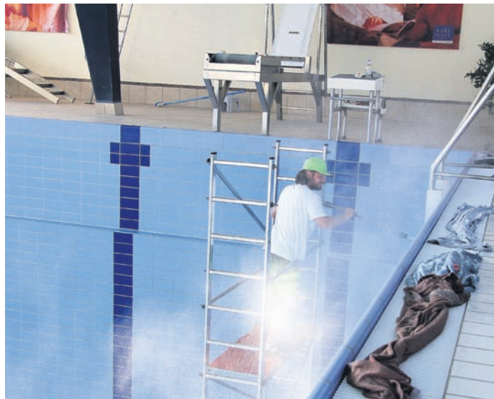
Das Schwimmerbecken wird mit einem Hochdruckstrahler gereinigt. (Foto: Stadt Rödermark)
