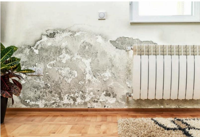
Durch Feuchtigkeit in Wänden entstehen Schimmel, Ausblühungen, Salpeter und Abplatzungen; die Bausubstanz wird angegriffen. Besteht das Problem schon länger und bleibt unbehandelt, wird die Wohnqualität eingeschränkt. Gesundheitliche Folgen sind nicht auszuschließen. Der Wert der Immobilie wird dadurch nachhaltig gemindert.
