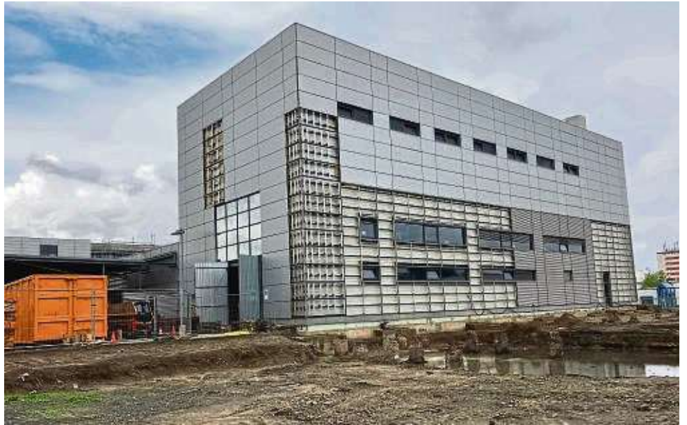
Einer der nächsten Schritte beim Umbau der Druckerei an der Waldstraße ist die Vergrößerung der Halle an der Stirnseite, wo bereits Baggerarbeiten im Gange sind.
