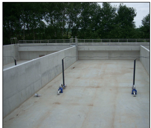
[Bild 17: Frachtspeicher- u. Pufferbecken]
