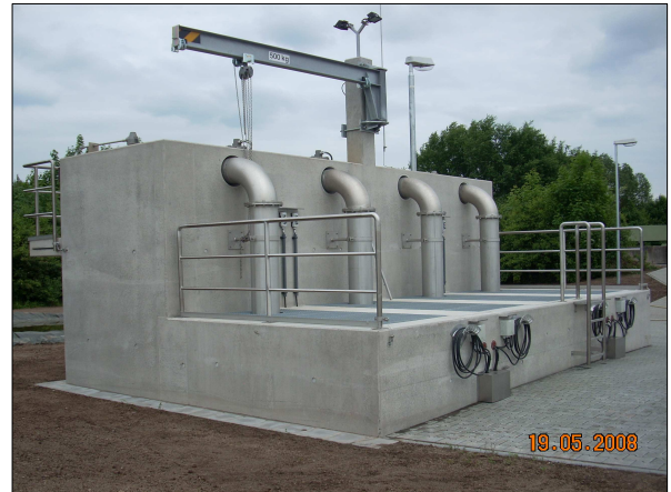
[Bild 16: Neubau Rezirkulationspumpwerk]
