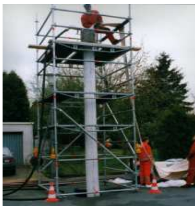
[Bilder 7 bis 9: li. u. mi. → grabenloses Reliningverfahren, re. → hydraulische Kanalerneuerung]
