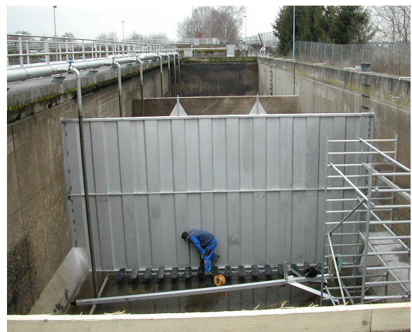
[Bild 15: Austausch Lüfterplatten und Einbau einer Kaskade ins Nitrifikationsbecken]
