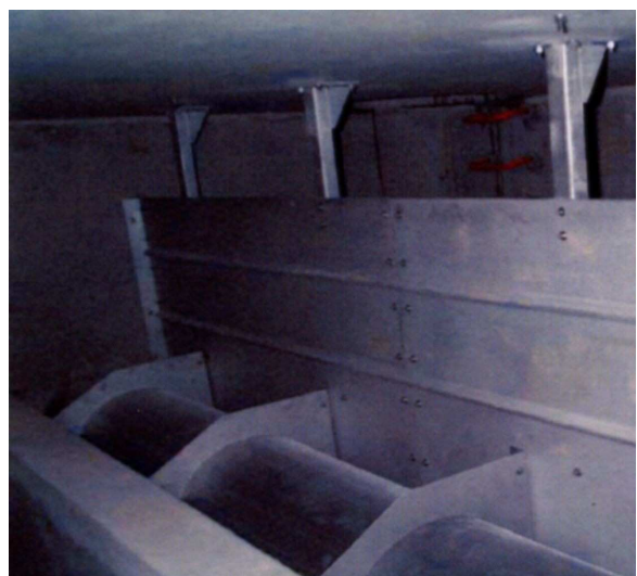
[Bilder 10 + 11: Siebanlage im B 25 "Am Hallenbad"]
