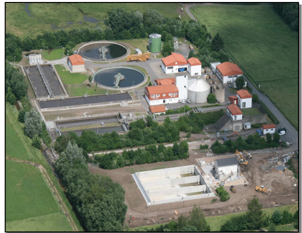
[Bild 12: Kläranlage Ober-Roden]
