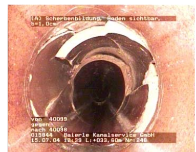
[Bilder 33 bis 35: Kanalschäden – li. einwachsende Wurzeln, Mi. einragender Stutzen, re. Einbruch]
