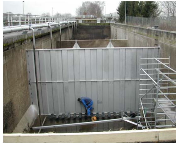
[Bild 39 + 40: li. Austausch der Lüfterplatten im Nitrifikationsbecken; re. Einbau einer Kaskade]
