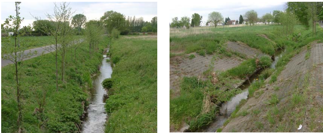
[Bild 25 + 26: Rodau zwischen Urberach und Ober-Roden; Kanalartiger Ausbau]
