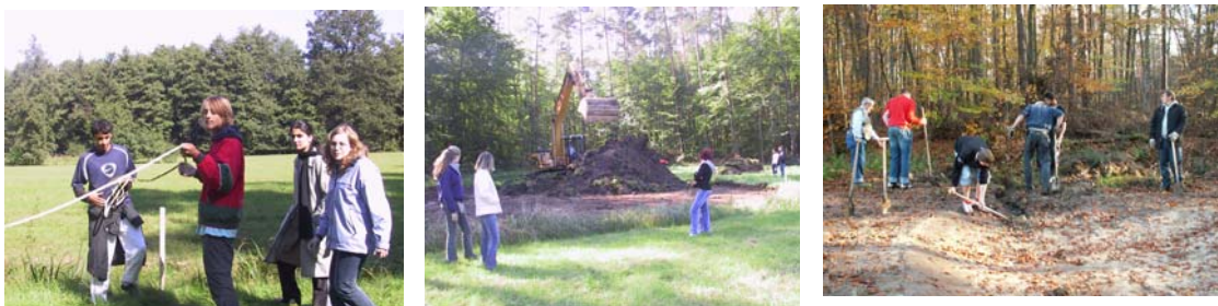
[Bilder 55 bis 57: links → Abstecken der Teichgröße; Mitte → Aushub des Teiches; rechts rechts → Anlegen von Wasserzuläufen]
