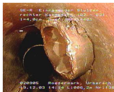
[Bilder 33 bis 35: Kanalschäden – li. einwachsende Wurzeln, Mi. einragender Stutzen, re. Einbruch]
