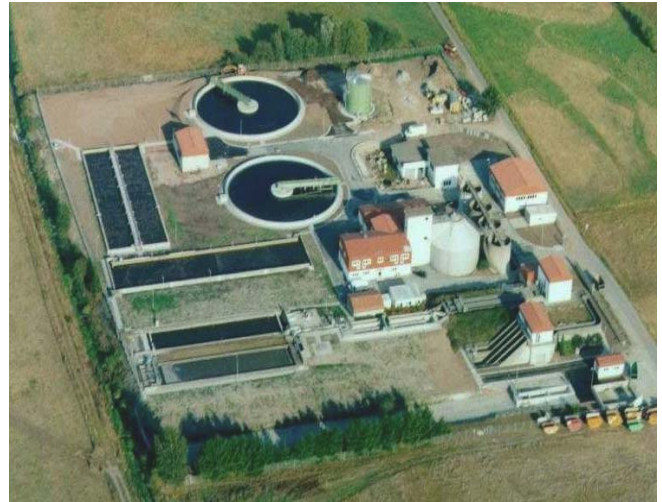
[Bild 32: Kläranlage Ober-Roden]
