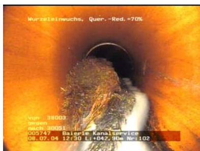
[Bilder 33 bis 35: Kanalschäden – li. einwachsende Wurzeln, Mi. einragender Stutzen, re. Einbruch]
