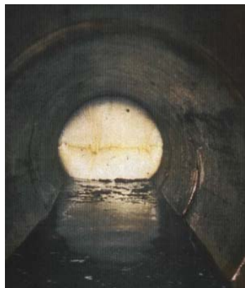
[Bilder 36 bis 38: li. u. mi. → grabenloses Rellingverfahren, re. → hydraulische Kanalerneuerung]
